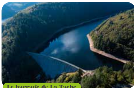
Le barrage de La Tâche
